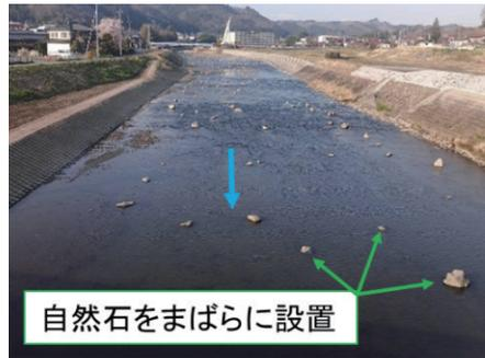
写真2. 水産と土木が考える環境配慮にずれが生じている事例
